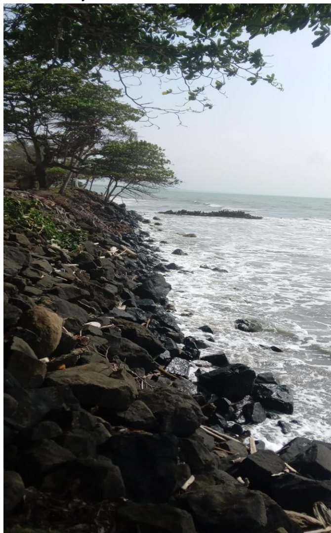
Figura 89. Muro de piedra en la costa.
