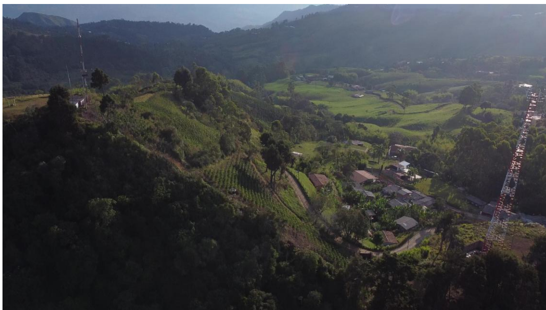
Figura 71. Déficit de agua y bombeo de agua en la zona alta del cerro Combia.
