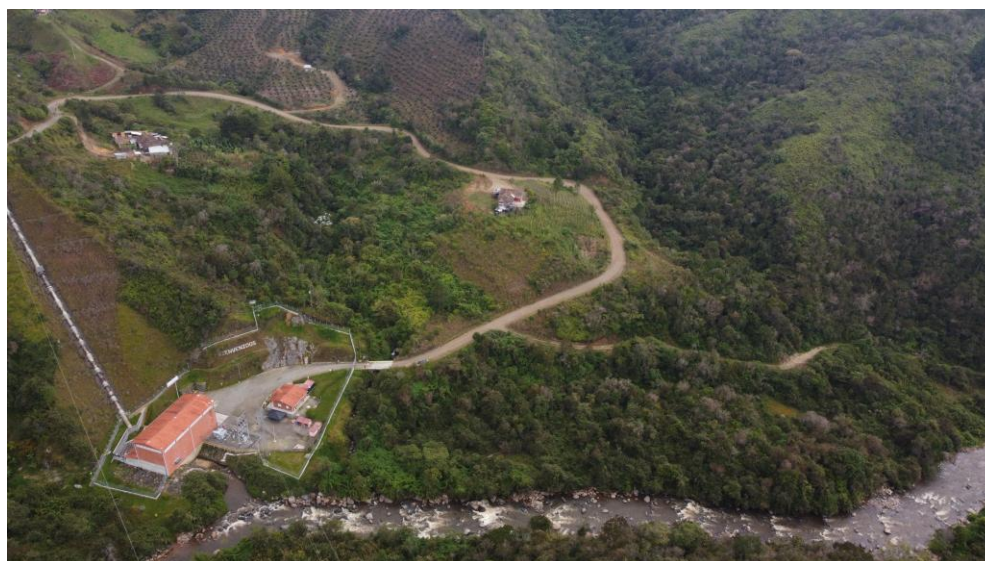
Figura 47. Casa de máquinas.
