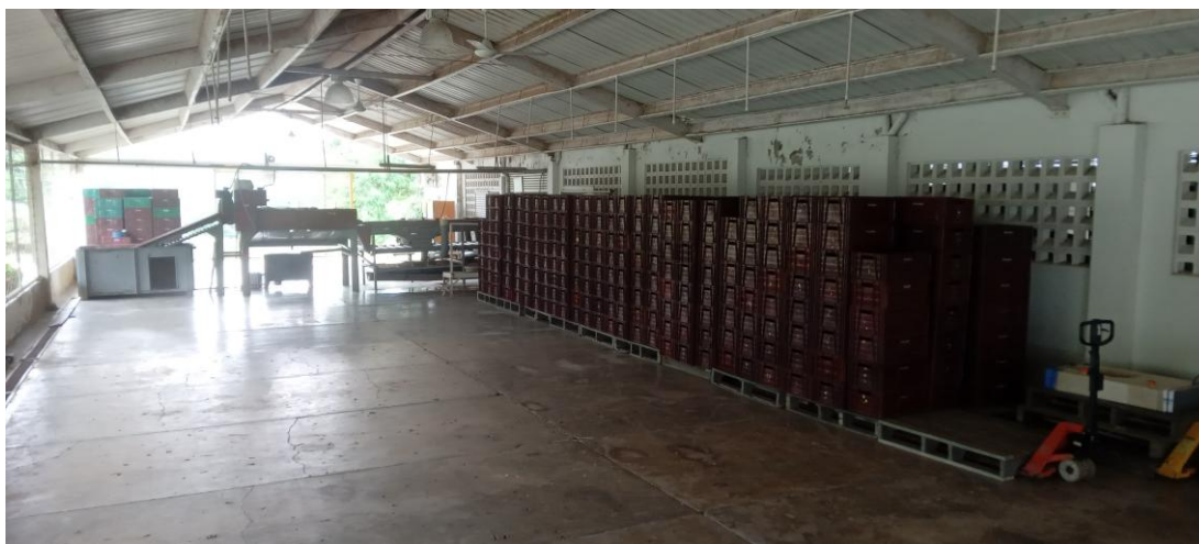
Figura 62. Planta de procesamiento sin funcionar.
