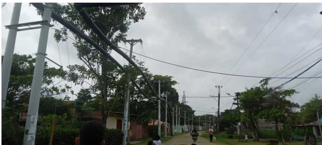
Figura 85. Acueducto aéreo del barrio Pescador.
